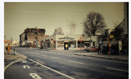
Behelfsbau Tapeten Kluge
