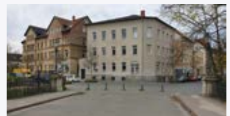
Foto 05: Ansicht 2023 vor der Sanierung. Foto Heiko Krause
