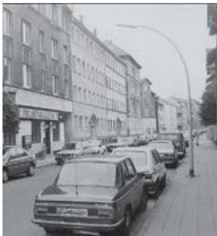
Der Felsenkeller nach dem Umzug in die Juliusstraße 33a, hier eine Aufnahme von 1994
