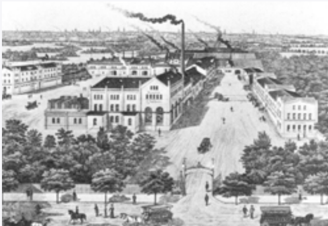
Historische Ansicht von der Broitzemer Straße. Foto: Archiv Krause
