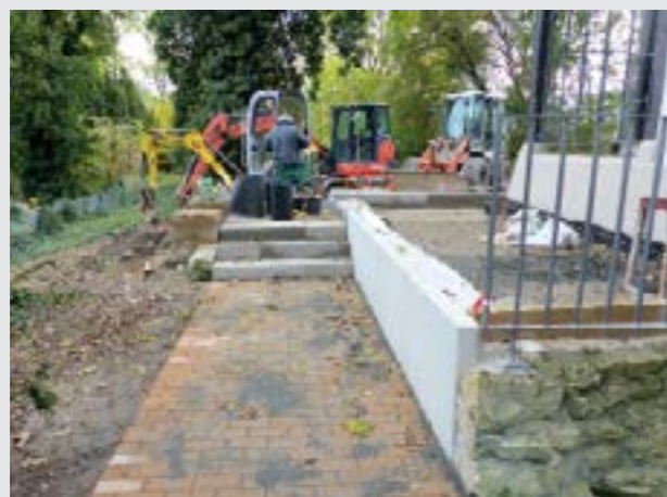
Rückseite mit neuem Zugang zum Keller
