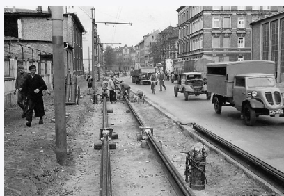
Gleisbau Frankfurter Straße 1949
