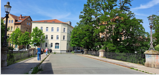
Blick über die Ferdinandbrücke
